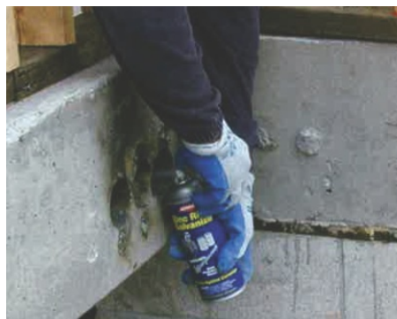
شکل ۶-۳۸- خارج کردن مواد اضافی از حفرات کشش و اسپری مواد ضد خوردگی مانند گالوانیزه‌کننده با پایه روی ۱ جهت محافظت بیشتر بر روی قسمت انتهایی تاندون
