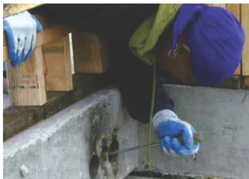
شکل ۶-۳۸- خارج کردن مواد اضافی از حفرات کشش و اسپری مواد ضد خوردگی مانند گالوانیزه‌کننده با پایه روی ۱ جهت محافظت بیشتر بر روی قسمت انتهایی تاندون
