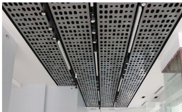
ب- ورق سورخدار توسط دستگاه پانچ یا CNC
