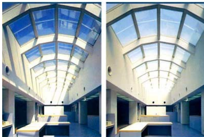
شکل ۱۲-۷۲- نمونه پوشش شفاف سقف با شیشه‌های فتوکرومیک
