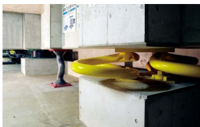
(ج) میراگر تسلیمی سربی و تسلیمی فولادی
