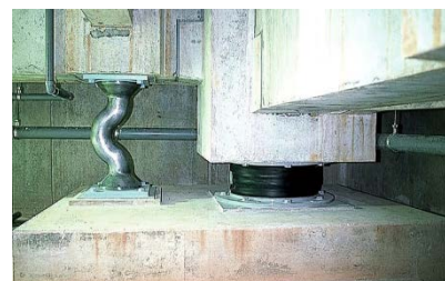
(الف) میراگر تسلیمی سربی
