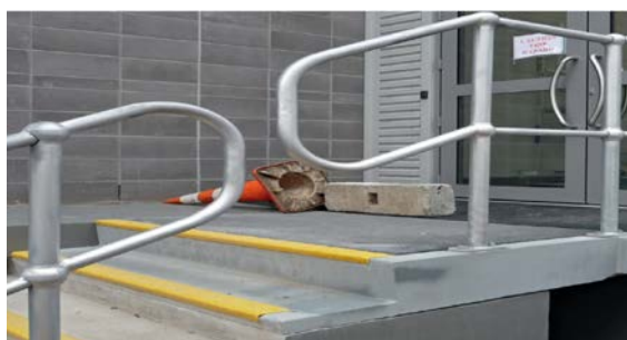
پاگرد پله از ساختمان کنسول شده و بر روی ستونک می لغزد. دستگیره‌ها برای اینکه مانع حرکت نشوند، از هم جدا شده‌اند
