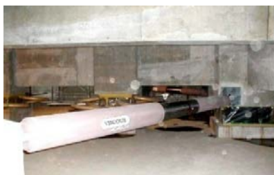
(ث) میراگر ویسکوز و تسلیمی فولادی
