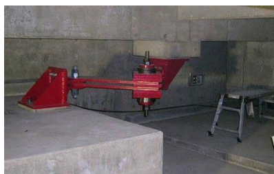
(پ) میراگر اصطکاکی
