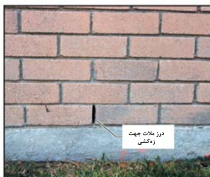
شکل ۵-۱۳- خالی گذاشتن درز ملات جهت زه‌کشی
