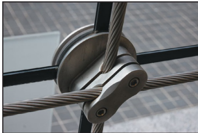
شکل ۹-۱۹- اتصال رایج در نقطه تلاقی کابل‌ها (اتصال کابل‌ها را به یکدیگر متصل نگه داشته و تکیه گاه لازم برای شیشه را نیز فراهم می‌کند. گوشه‌های ۴ شیشه در هر اتصال به یکدیگر می‌رسند.
