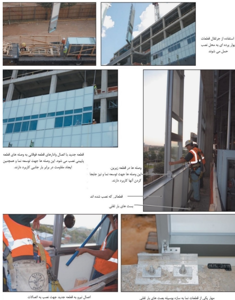
شکل ۹-۱۲- مراحل نصب نمای پرده‌ای یکپارچه
