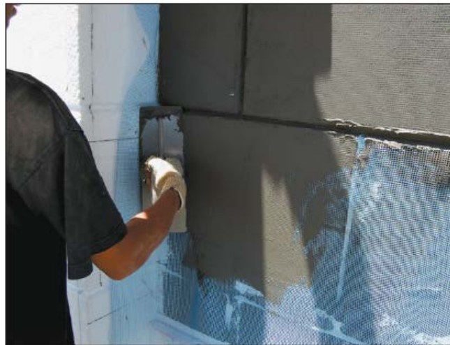
شکل ۱۱-۷- اجرای لایه‌های پوششی
