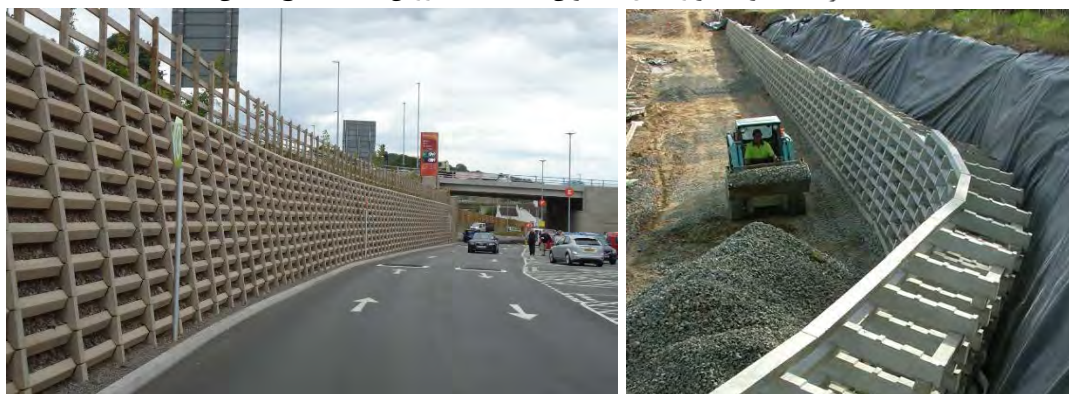
نگاره ۵۶: نمونه دیوار حائل بتنی از قطعات پیش‌ساخته گهواره‌ای؛ نیوزلند
