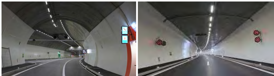
نگاره ۱۳۶: عدم نورپردازی داخل تونل و هدایت دید راننده با رنگ سفید بدنه، تونل آیهولز گذرگاه A ۹ سوئیس
