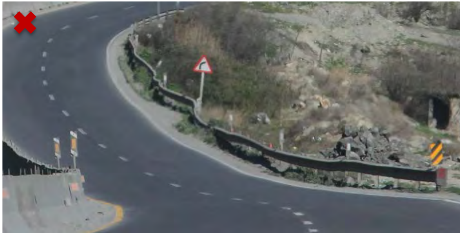
نگاره ۱۹۶: ضرورت رسیدگی دوره‌ای، تعمیر و تعویض حفاظ‌های آسیب‌دیده
