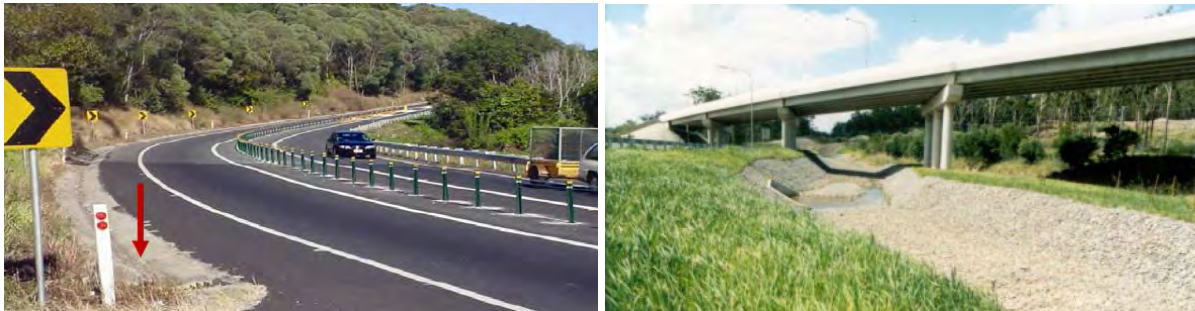
نگاره ۸۳: راست: آبروی خطی با بستر پوشیده از سنگ، استرالیا؛ چپ: کانیو ۱ جمع‌آوری آب سطح جاده پاسیفیک، نیوولز جنوبی استرالیا
