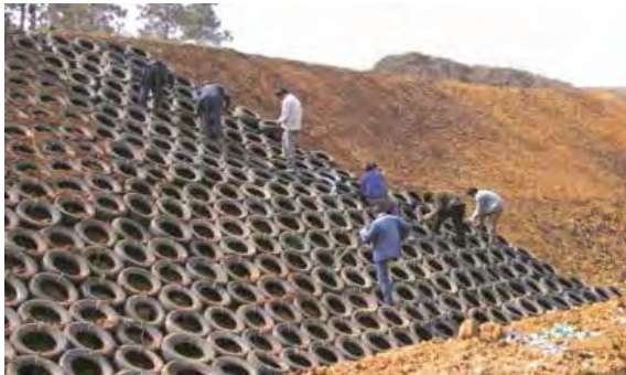
نگاره ۱۷۱: تثبیت ترانسه با اجرای ژئوسل یا تایرهای مستعمل - چین
