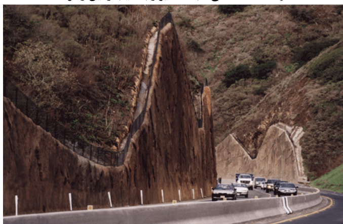
نگاره ۴۴: اجرای دیوار با شمع و با فرم و نمای طبیعی، جنوب شرق آسیا
