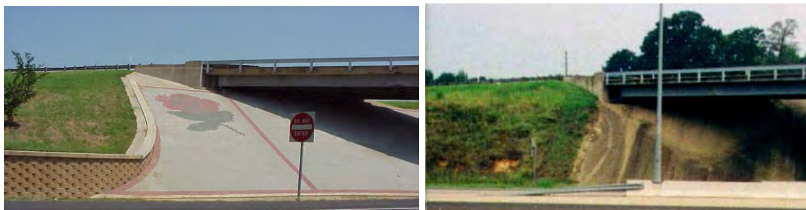
نگاره ۴۲: اجرای Rip-rap تکیه گاه پل با سنگ های روشن و طرح های محلی با هویت، تگزاس
