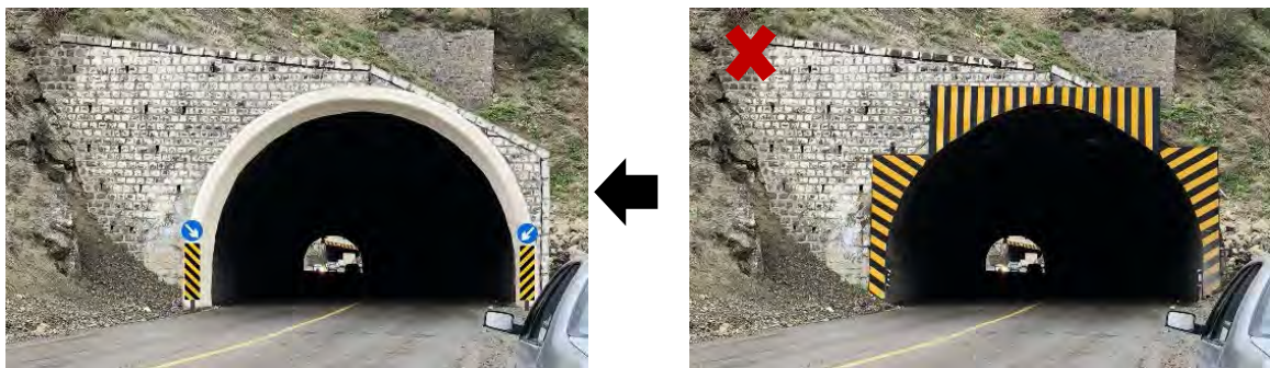
نگاره ۹۳: نصب علائم حول دهانه تونل طبق ضوابط و استانداردها
