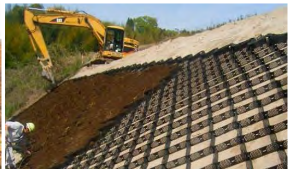
نگاره ۱۷۱: تثبیت ترانسه با اجرای ژئوسل یا تایرهای مستعمل - چین
