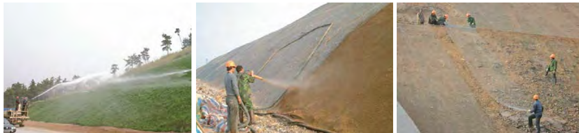
نگاره ۴۱: تثبیت ترانشه با گسترده شبکه mesh، پخش ماسه و بذر و رویش پوشش گیاهی، چین
