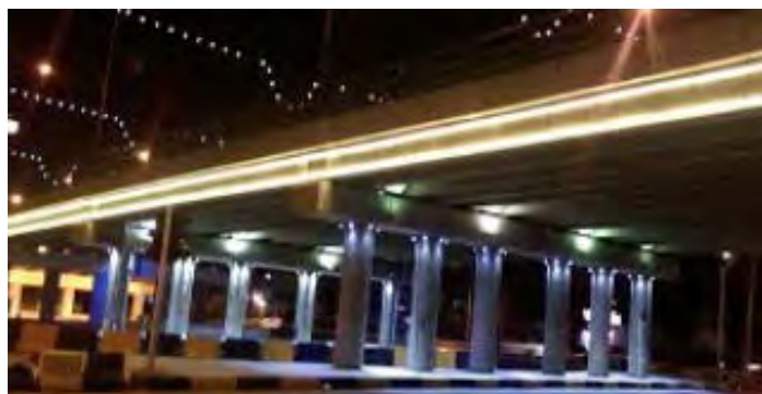
نگاره ۱۳۰: استفاده از ریتم در نورپردازی ستون‌های پل
