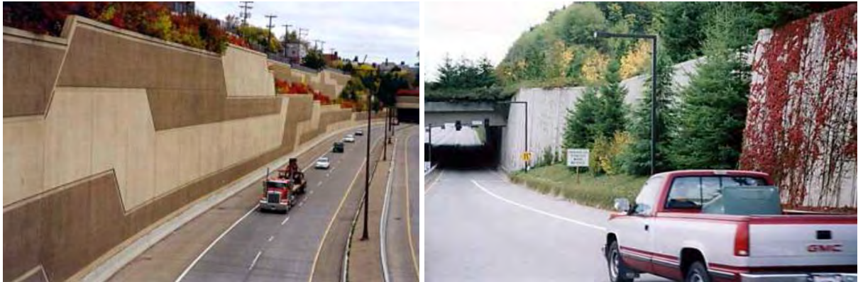
نگاره ۴۹: ایجاد تنوع با عقب‌نشینی دیوار و ترکیب با کاشت (راست) و استفاده از رنگ و طرح و پلکان گلجای (چپ)
