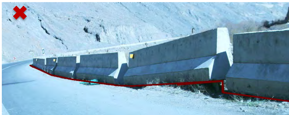
نگاره ۷۳: نصب غیراصولی نیوجرسی بدون تسطیح زمین، جاده هراز
