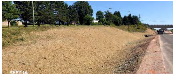
نگاره ۱۷۲: تثبیت ترانسه و راه آب آزهکش طولی به روش بذرپاشی دوغابی
