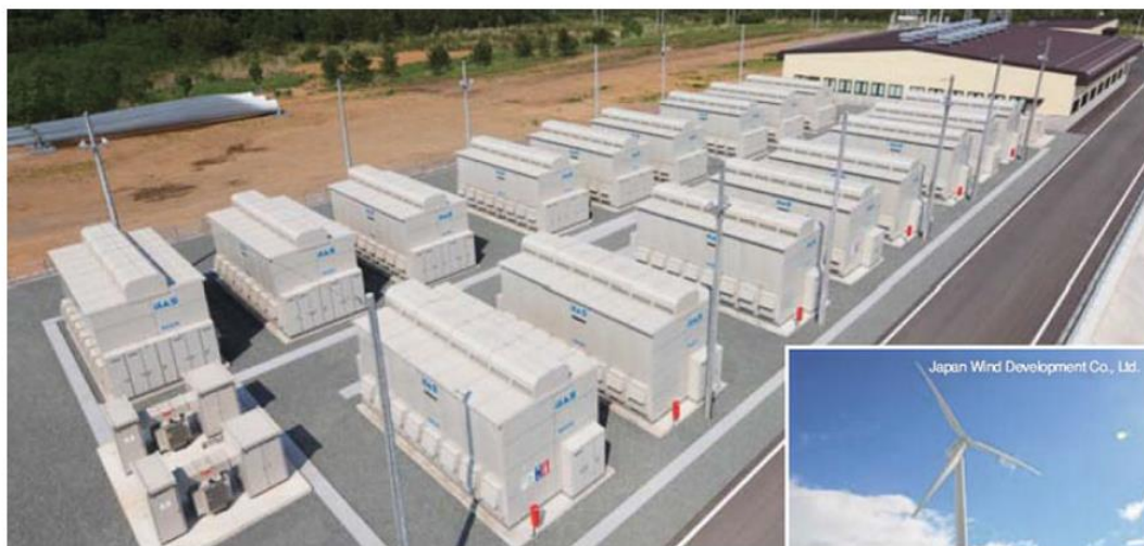
شکل ۵-۸: سیستم بلوک سدیم سولفور با ظرفیت ۳۴ مگاوات
