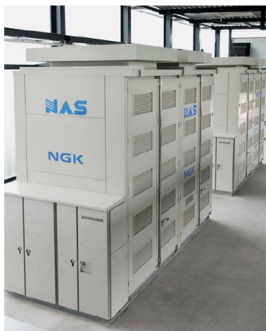
شکل ۵-۶: سیستم بلوک باتری سدیم سولفور نمونه
