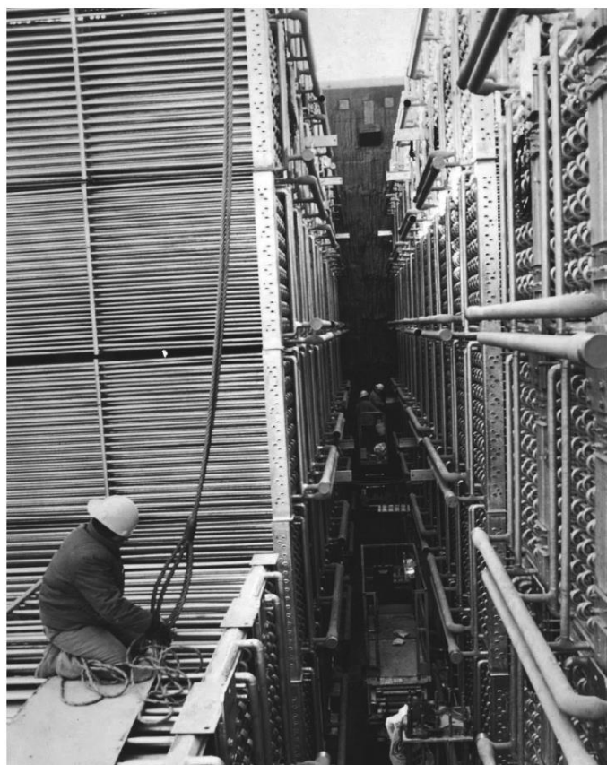
شکل ۸-۱۵: نصب مخزن برای یک سیستم ذوب از خارج یخ روی کویل
