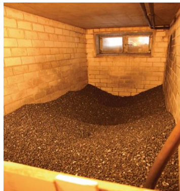
شکل ۴-۱۶: انبار خانگی ذخیره‌سازی ذغال سنگ سخت برای تامین گرما
