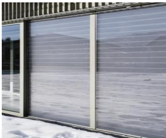
شکل ۵-۱۳: استفاده از مواد تغییر فازدهنده در فضای بین شیشه‌های یک ساختمان
