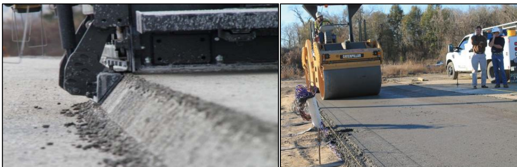
شکل ۶-۳۷- نمونه‌ای از بتن غلتکی
