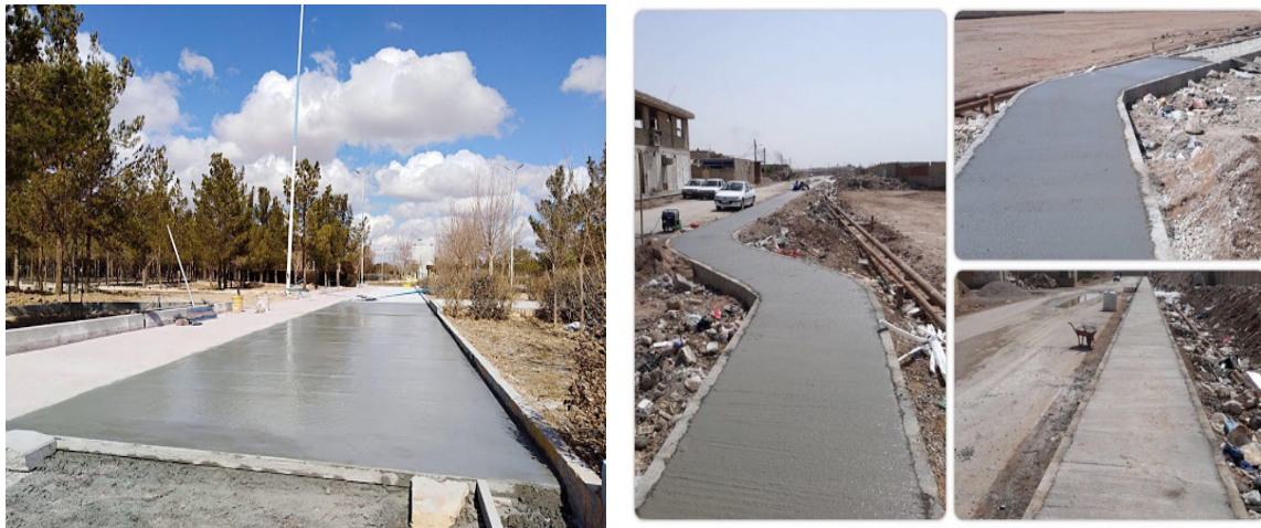
شکل ۴-۸- نمونه مسیر پیاده با رویه بتن درجا
