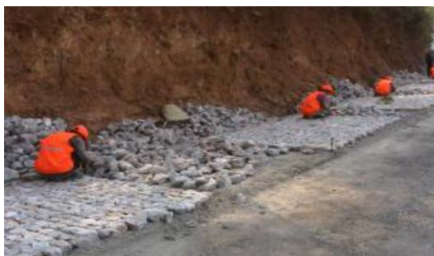
شکل ۶-۹- نمونه‌ای از معبر با رویه قلوه سنگ دستچین
