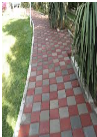
شکل ۴-۷- نمونه مسیر پیاده با کف پوش بتنی (خشکه چینی)
