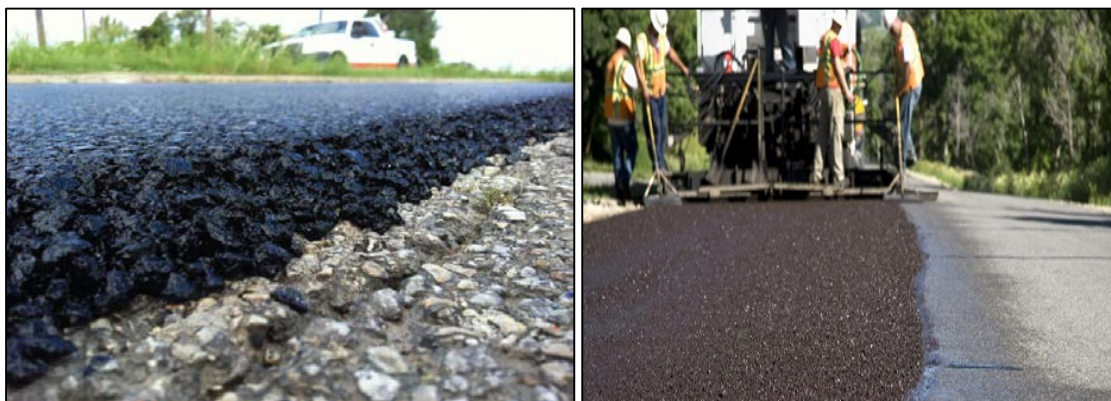
شکل ۶-۲۱- نمونه‌ای از میکروسرفیسینگ
