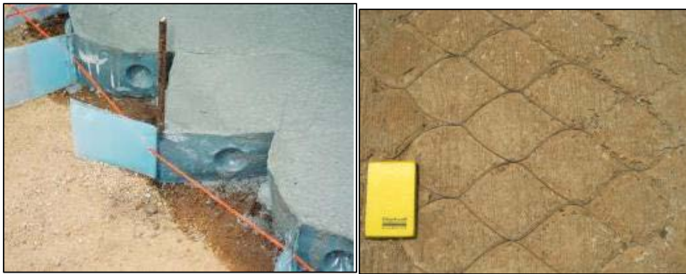
شکل ۶-۳۵- نمونه‌ای از رویه بتنی همراه با ژئوسل
