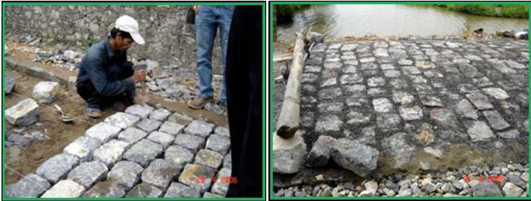
شکل ۶-۲۳- نمونه‌ای از سنگفرش بلوکی
