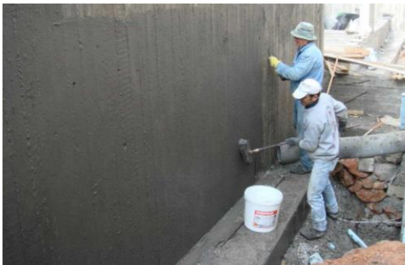
شکل ۱-۱۰- نمای از پوشش سیمانی چند جزئی
