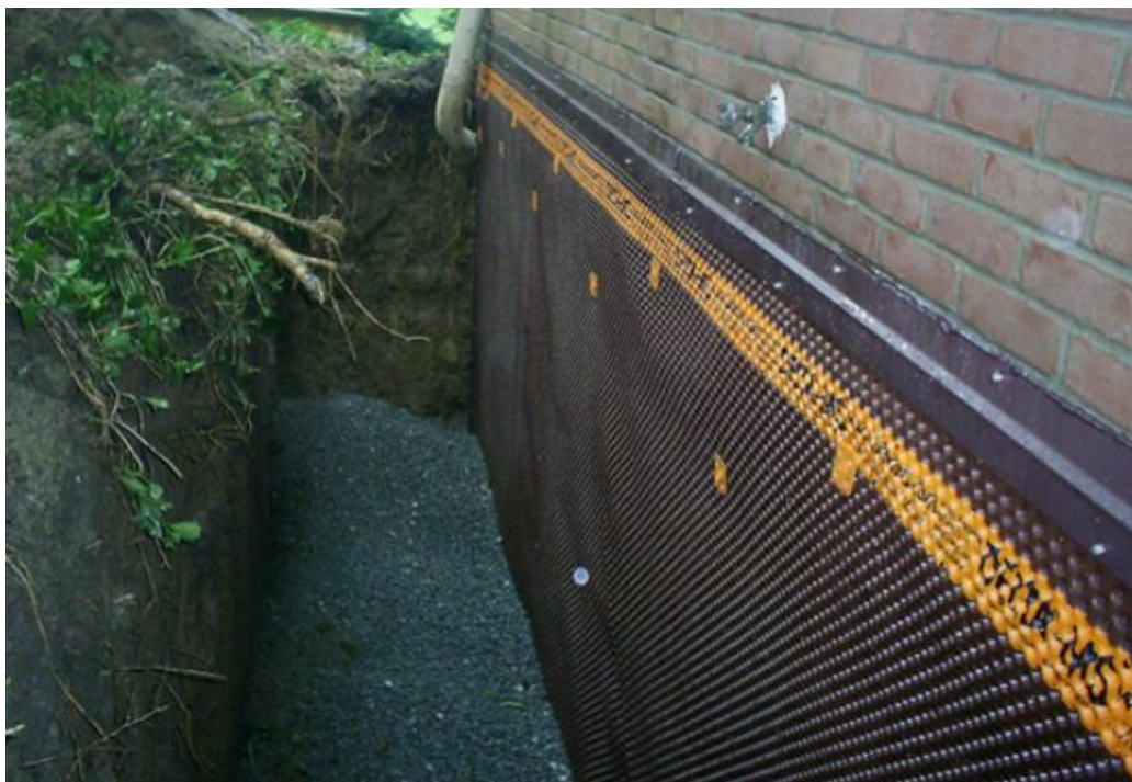
شکل ۱-۱۷- نمای از سیستم زهکشی خارجی
