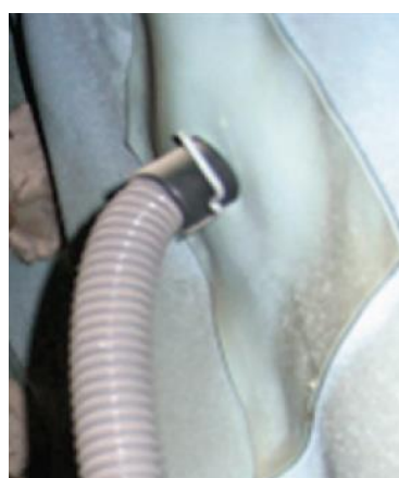
شکل ۶-۷- نازل تزریق با شلنگ‌های پرکننده
