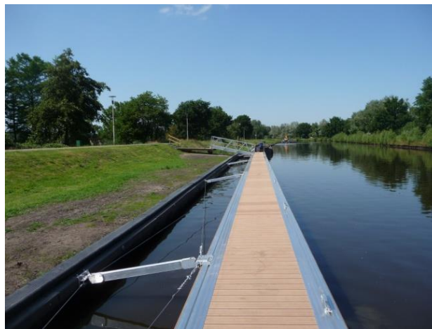
شکل ۳-۲۲ - سیستم مهاربندی با تیر ۱ و طناب
