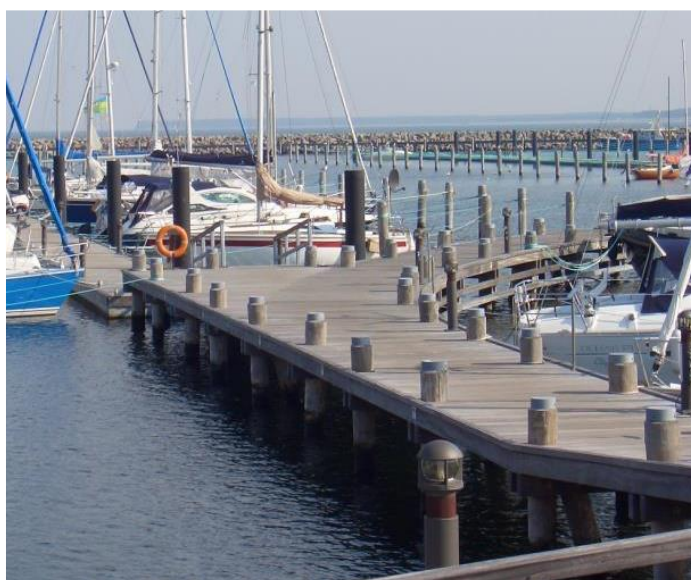
شکل ۳-۱۸- اسکله شمع و عرشه
