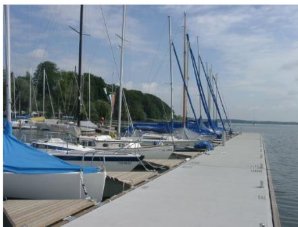
اسکله شناور با پوشش بتنی
