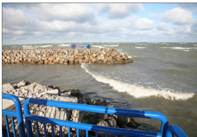
شکل ۳-۹ - شکست امواج در ورودی حوضچه شناورها
