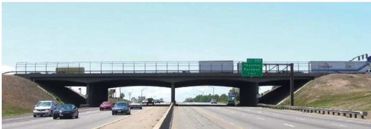
شکل ۶-۳- نمونه سازه غیرهمسطح با کوله باز
