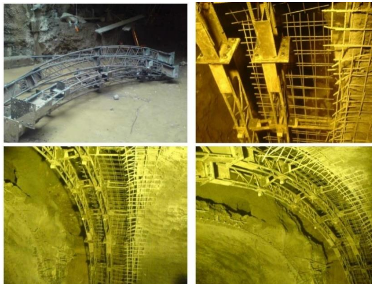
شکل ۷-۴- لتیس‌گریدر و نصب آن
