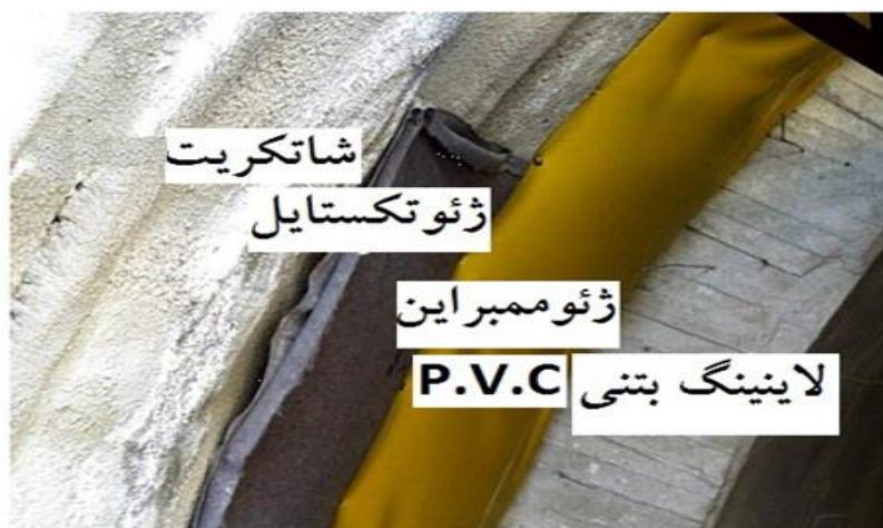
شکل ۶-۲۱- شماتیک لایه‌بندی سیستم نگهداری و آب‌بندی تونل
