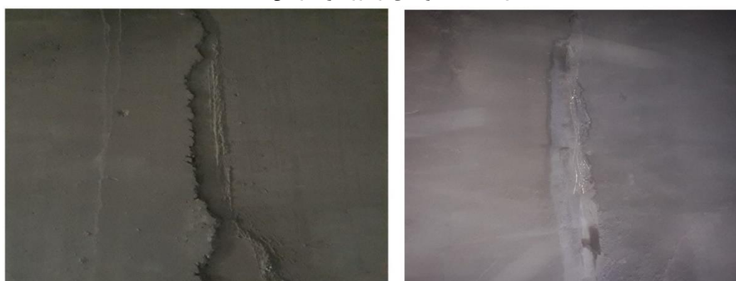
شکل ۶-۱۶- درزهای اجرایی در بتن لاینینگ
