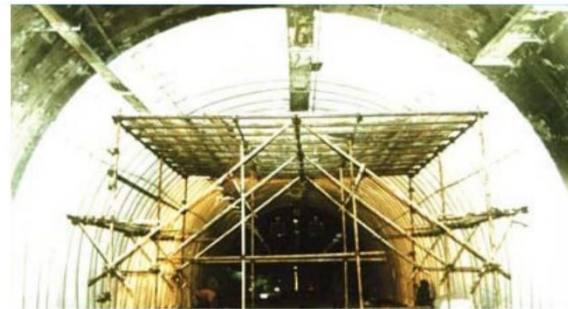
شکل ۶-۲۰- اجرای عایق بندی
