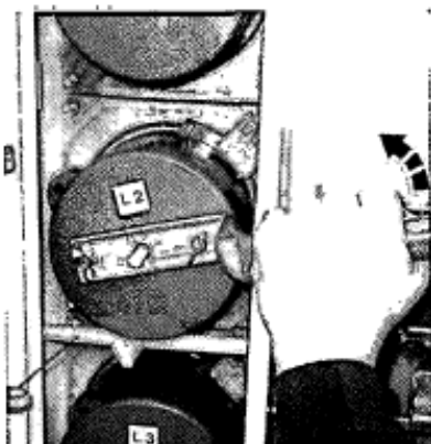
شکل ۴-۱۲۴ مراحل تعویض فیوز
