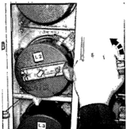
شکل ۴-۱۱۶ مراحل تعویض فیوز
