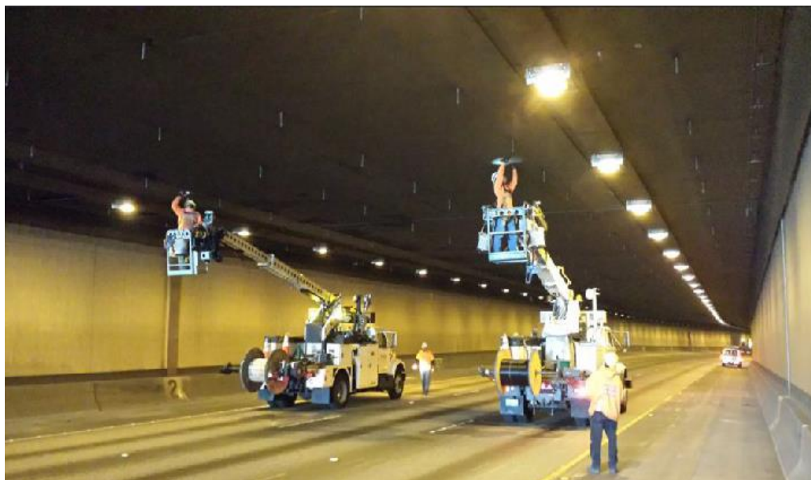
شکل ۷-۳ بازرسی پوشش تونل با استفاده از بالابر
