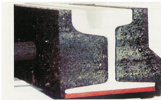
شکل ۲-۳ جزئیات ریل قاشقی، نوار دو لایه CDM و پرکننده‌های جان ریل
