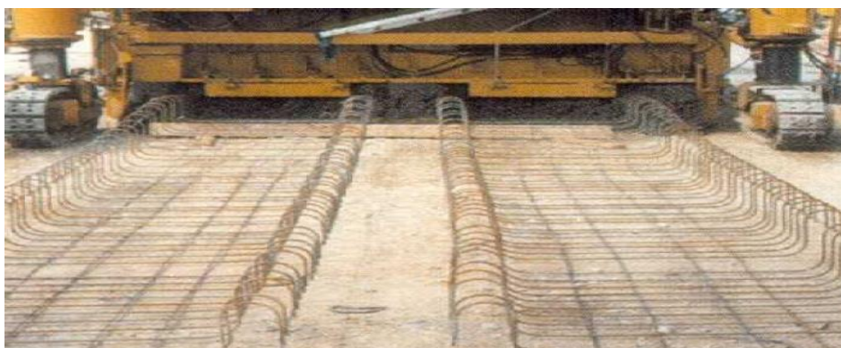
شکل ۲-۱۱ اجرای آرماتور دال بستر سیستم والو
