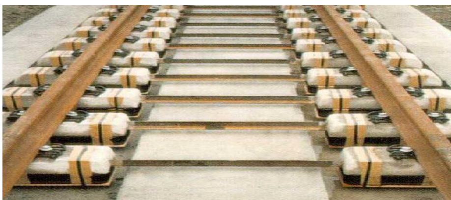
شکل ۲-۱۲ نصب تراورسها در بستر سیستم والو
