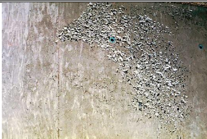
شکل ۴۲→ نمونه بتن لانه زنبوری
