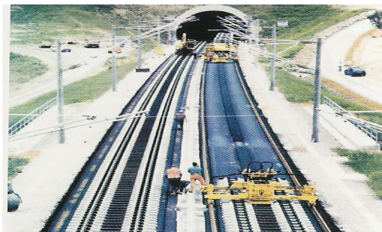
شکل ۲-۱۳ روسازی بتن آسفالتی در دست ساخت
