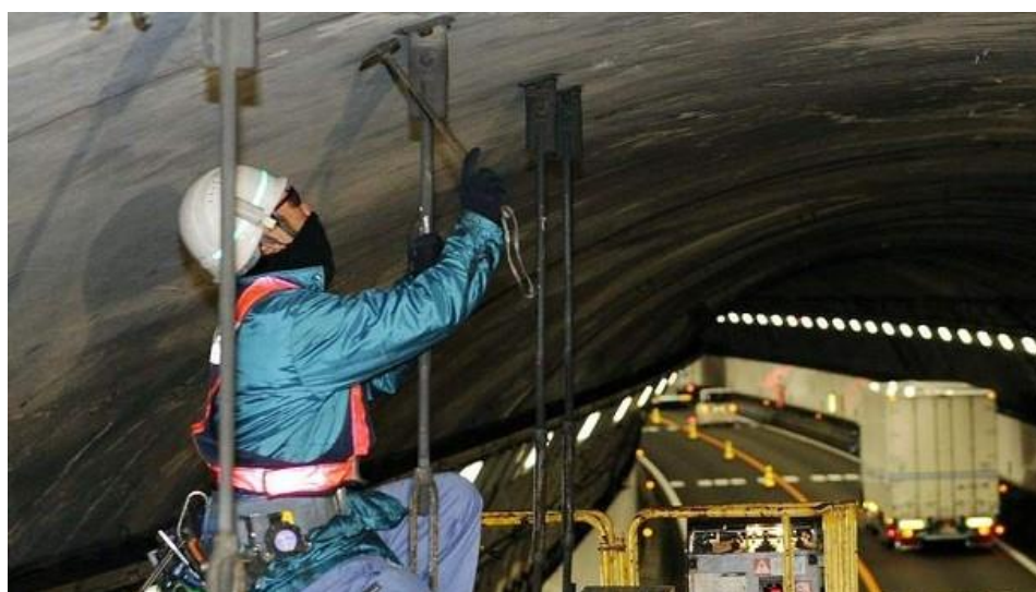
شکل ۱۰-۴ انجام چکش‌زنی بر روی سطوح فوقانی تونل
