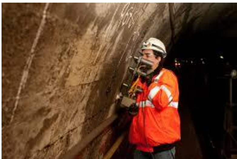
شکل ۴-۱ انجام مغزه‌گیری از دیوار تونل
