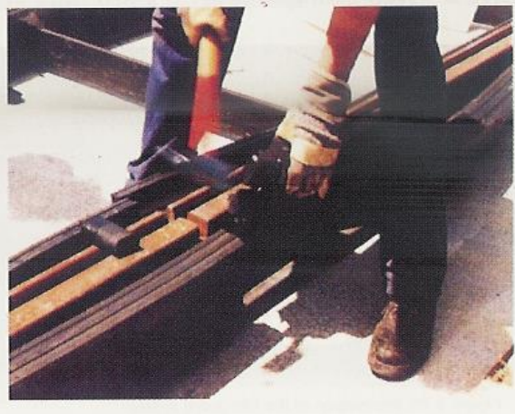
شکل ۲-۳۲ نصب پرکننده‌های جان
