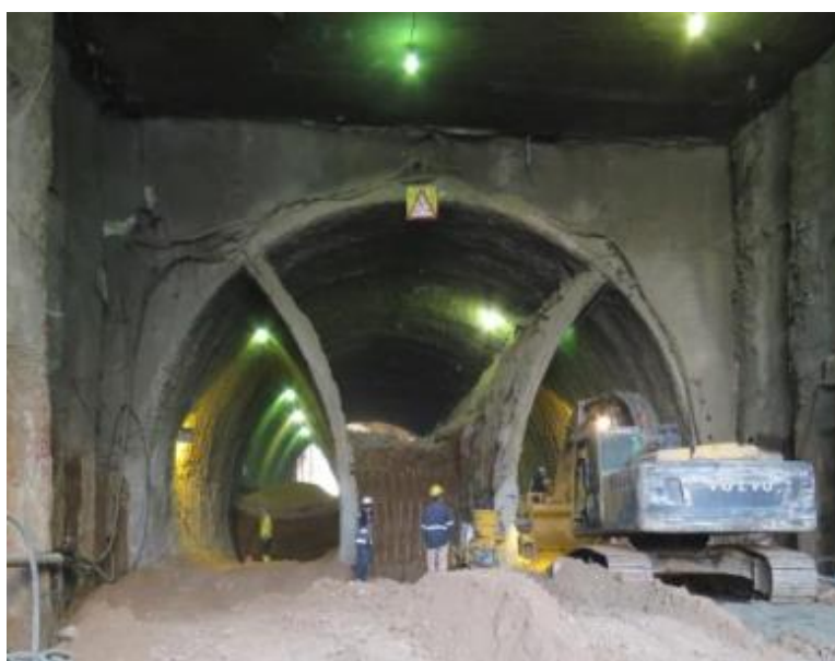
شکل ۳-۱۲: نمونه‌ای از اجرای تونل به روش گالری‌های جانبی (SD)
