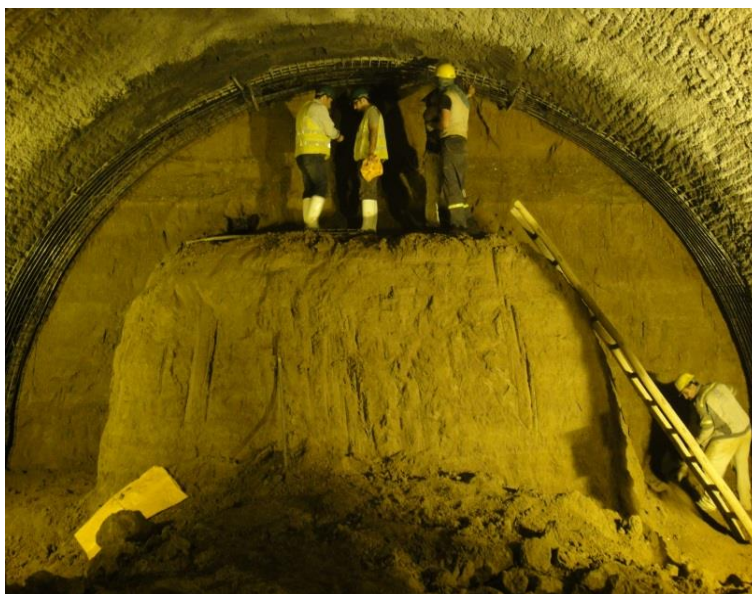
شکل ۳-۲۵: استفاده از core برای پایداری جبهه کار تونل و سکوی کمکی برای نصب سازه اولیه
