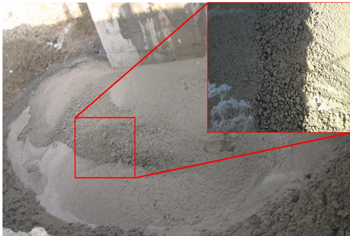
شکل ۲-۲۰: نمایی از کوبل‌های حفاری شده توسط ماشین EPB-TBM در محل دمپ مصالح حفاری
