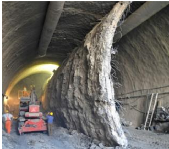
شکل ۳-۱۰: نمایی از اجرای روش دیوار میانی (CD)
