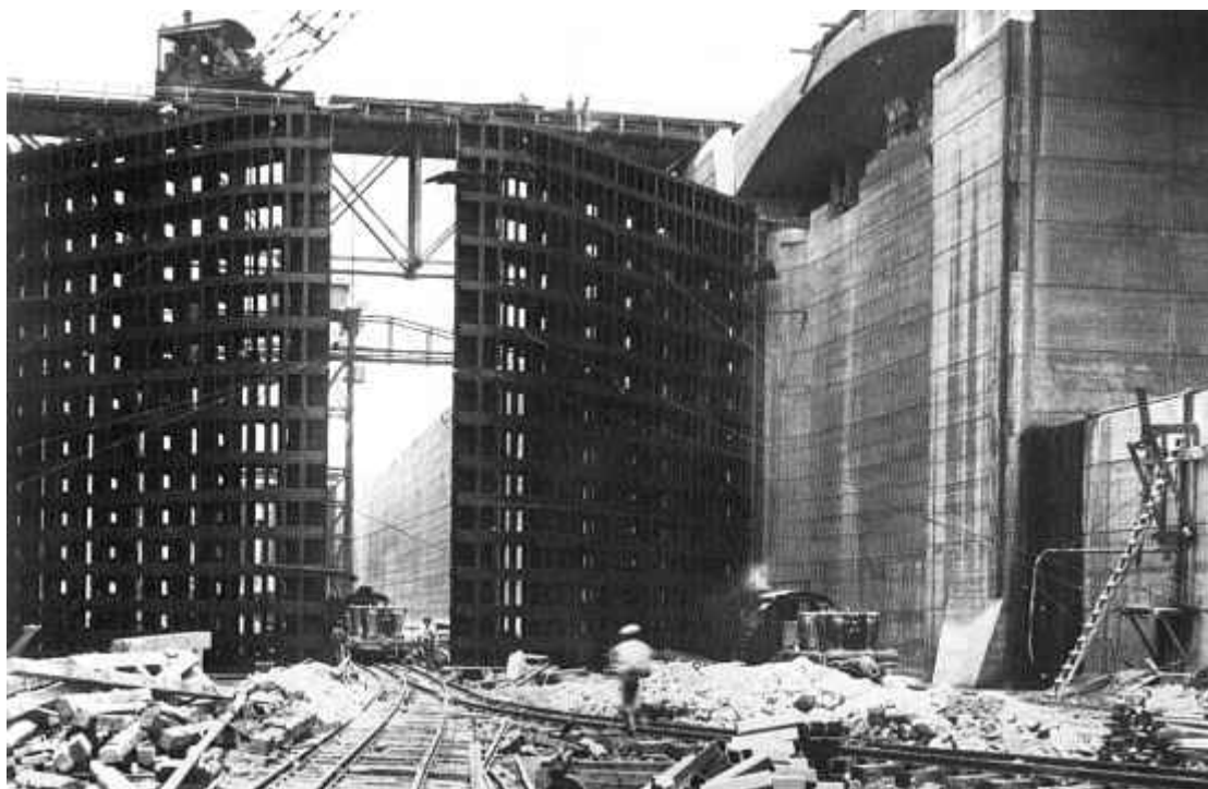
شکل ۱۰-۳. مراحل ساخت یکی از دریچه‌های قفل کشتیرانی در حال احداث (۱۹۱۳)
